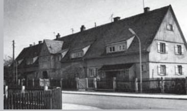
Eines der typischen kleinen Doppelhäuser mit Nutzgarten der Heimgartenbaugenossenschaft in der Georg-Jais-Straße/Ecke Zacharias-Werner-Straße, erbaut 1920
