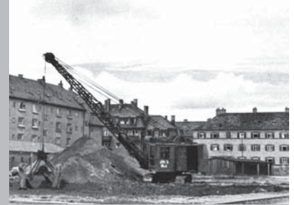
Baubeginn 1950 an der Nusselstraße/Ecke Josef-Lang-Straße Gemeinnützige Wohnungsgenossenschaft München-Pasing e. G.
