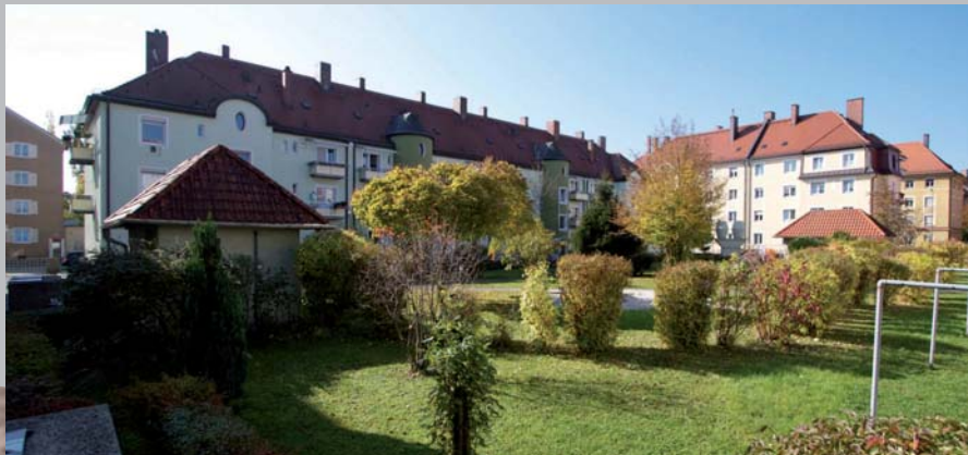
Der Innenhof des ersten Bauprojekts der Eisenbahnerbaugenossenschaft von 1909 etwa 100 Jahre später (Gräfstraße Ecke Georg-Habel-Straße) Eisenbahnerbaugenossenschaft München-Pasing e. G.
